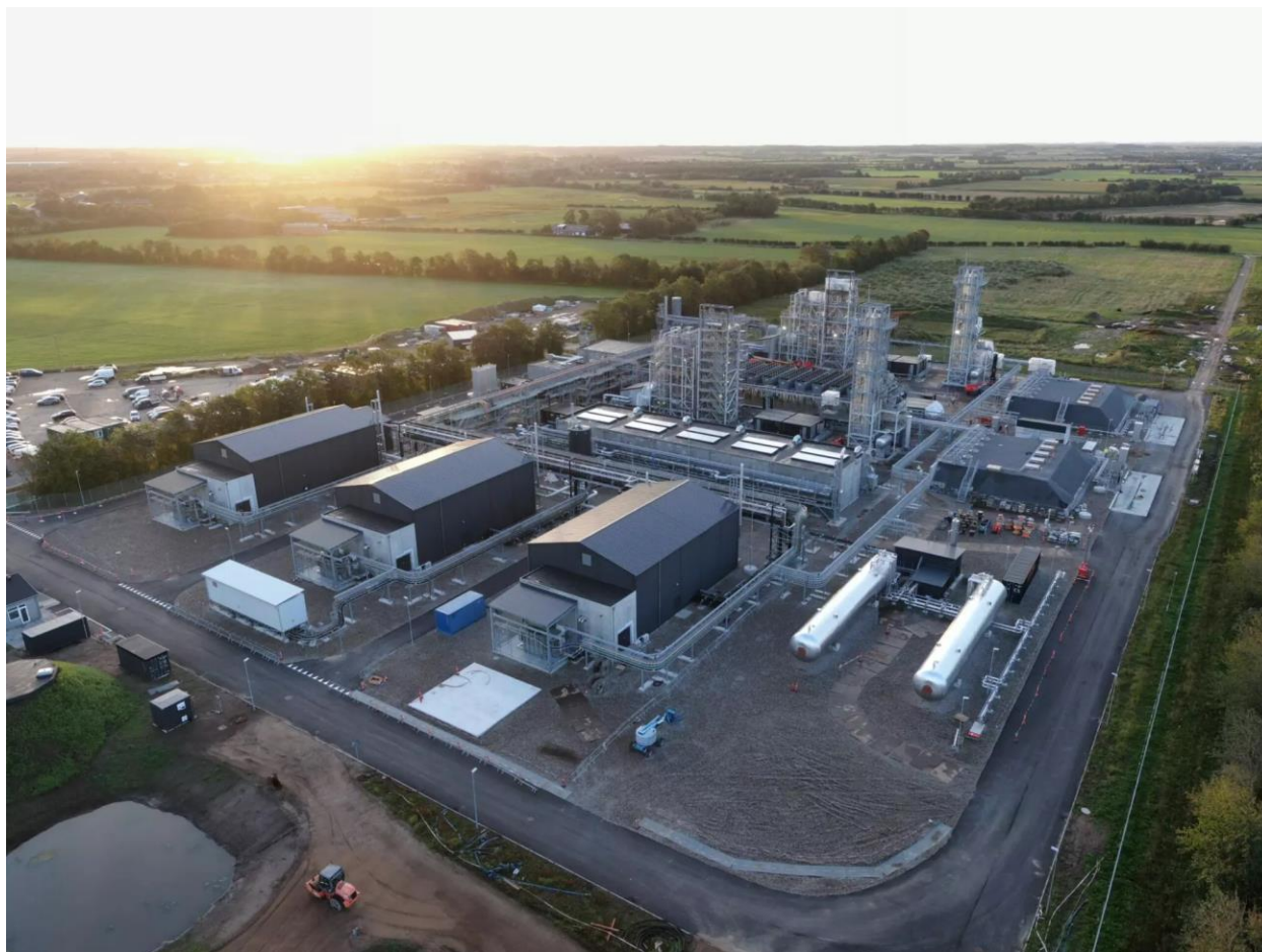
Εικόνα 22: Μονάδα παραγωγής PtX e-μεθανόλης της εταιρείας SPK στο Kassø, Δανία
